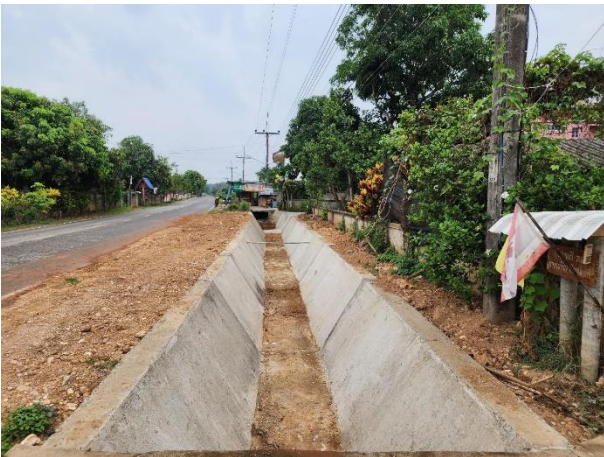
- โครงการก่อสร้างรางระบายน้ำคอนกรีตรูปตัววี หมู่ที่ 3 บ้านถ้ำ งบประมาณ 249,500 บาท
