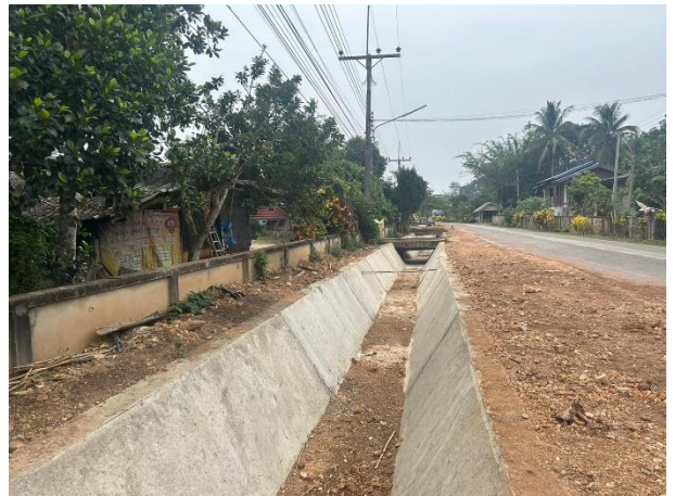
- โครงการก่อสร้างรางระบายน้ำคอนกรีตรูปตัววี หมู่ที่ 3 บ้านถ้ำ งบประมาณ 249,500 บาท
