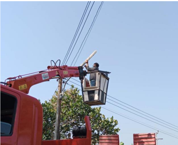
-ซ่อมแซมไฟฟ้าสาธารณะ
