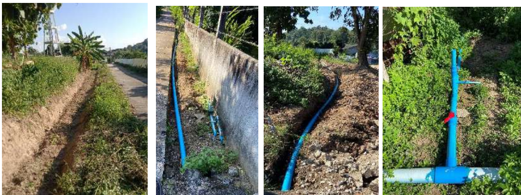
โครงการวางท่อระบบประปาหมู่บ้าน หมู่ที่ 9 บ้านหัวฝาย งบประมาณ 45,000 บาท
