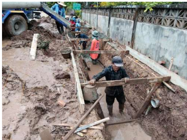
โครงการก่อสร้างรางระบายน้ำคอนกรีตเสริมเหล็กรูปตัววี หมู่ที่ 11 บ้านป่าเปา งบประมาณ 268,000 บาท
