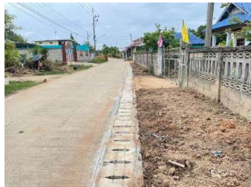
โครงการก่อสร้างรางระบายน้ำคอนกรีตเสริมเหล็กกรุปตัวยู หมู่ที่ 4 บ้านป่าข่า งบประมาณ 299,000 บาท
