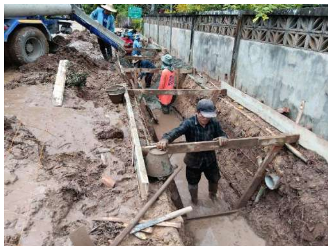
โครงการก่อสร้างรางระบายน้ำคอนกรีตเสริมเหล็กกรุปตัววี หมู่ที่ 11 บ้านป่าเปา งบประมาณ 268,000 บาท
